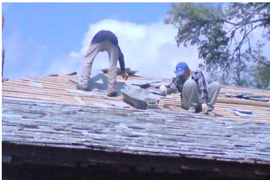
Εργάτες ανακαινίζουν τη στέγη της Αγίας Μαρίνας (Σεπτέμβριος 2009)
