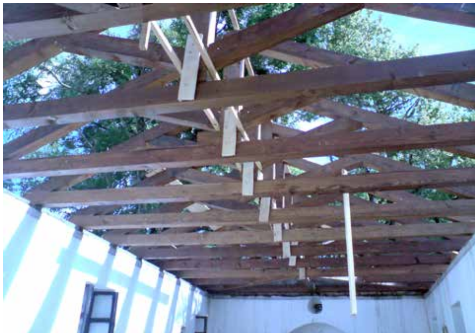
Η ανακαινισθείσα στέγη της Αγίας Μαρίνας (2009)
